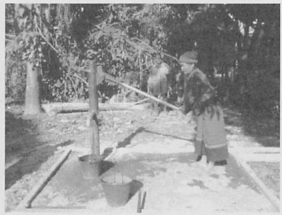
JICAの支援で設置された深井戸
